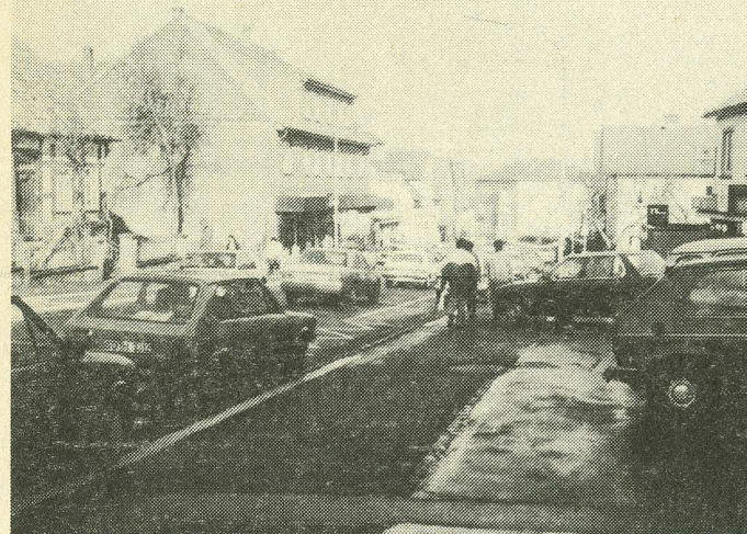
Handlungsbedarf sieht die SPD für die Sanierung der Oeseder Straße.
