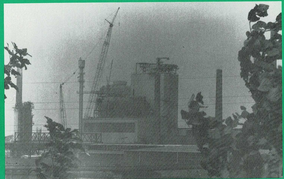
Die neue KS-Anlage im Bau
