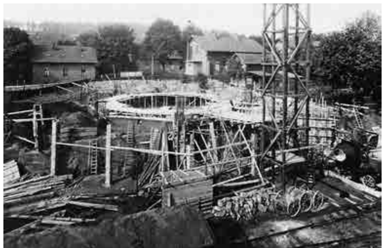
Rechts: Bau des ersten Kühlturms für die Turbinen der Kraftwerkshallen an der Kaiser- / Klöcknerstraße.
