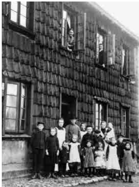
Die 1856 gebauten »Harzer Häuser« der Arbeiterkolonie Osterberg waren an den Außenfassaden mit Ziegeln verkleidet, die gegen Regen und Wind schützen sollten, und sahen für die Region Osnabrück ungewöhnlich aus
