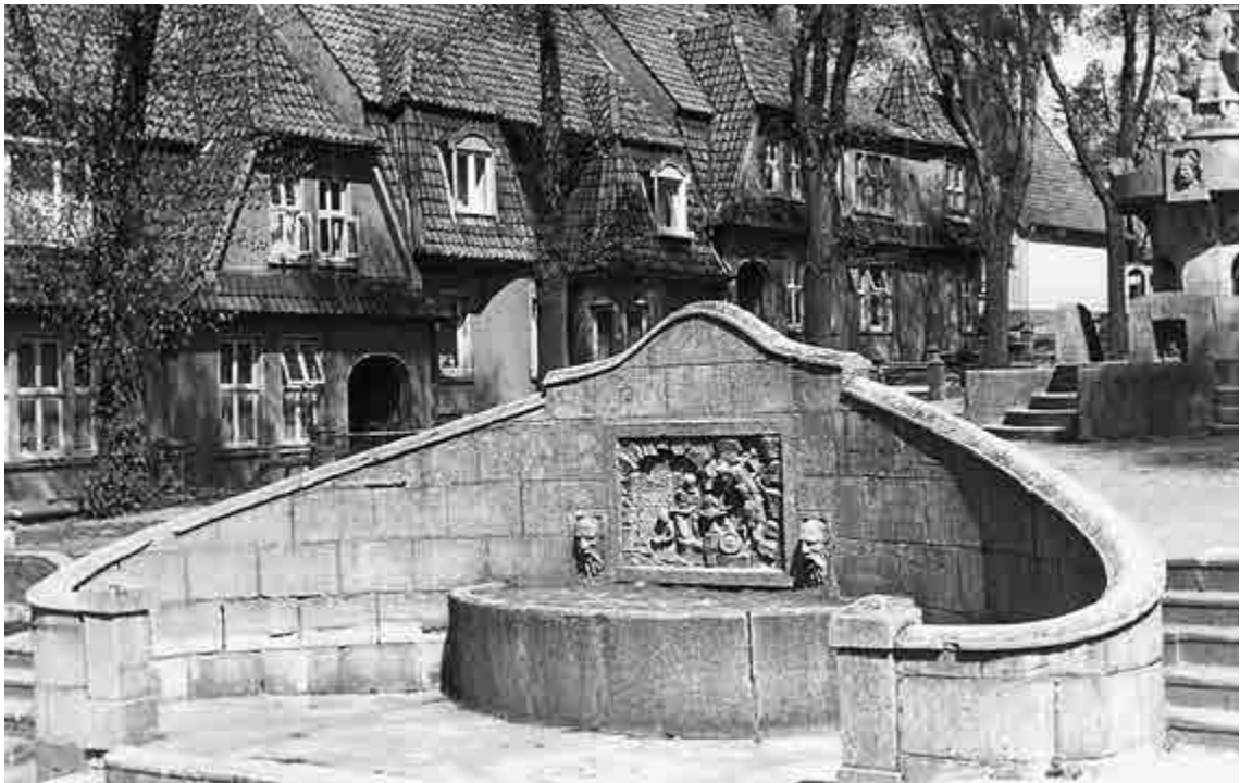
Die Grotte mit Sitzbereichen, Wasserbecken und kunstvoll gestaltetem Relief stand am unteren Ende des Marktplatzes.
