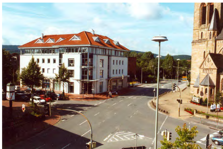
Nach dem Abriss der Gaststätte Casmann in den 1990er Jahren errichtete die Volksbank an dieser zentralen Stelle ein Geschäftshaus
