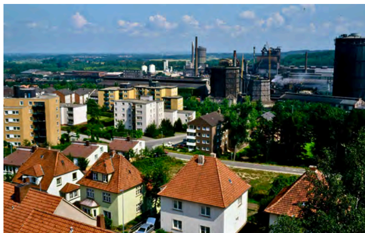
Nach der Flächensanierung um 1970 entstand die heute noch bestehende Wohnsiedlung
