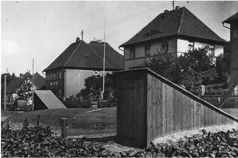
Selbst gebaute Bunker in Gärten der Hindenburgstraße, damals Adolf-Hitler-Straße
