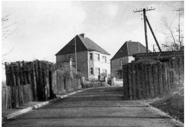
Von G.M.Hütter Volkssturm-Männern im Frühjahr 1945 angelegte »Panzersperre« an der Hindenburgstraße nahe der Abzweigung zur »Oberen Findelstätte«. Beim Einmarsch der feindlichen Truppen in Georgsmarienhütte am 3. April 1945 wurde diese und andere Panzersperren in GMHütte aber nicht von Volkssturm-Männern besetzt, sondern der Ort den britischen Truppen kampfflos übergeben.
