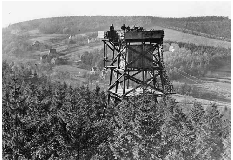
Einer von drei Türmen der Flakstellung auf dem Lammersbrink
