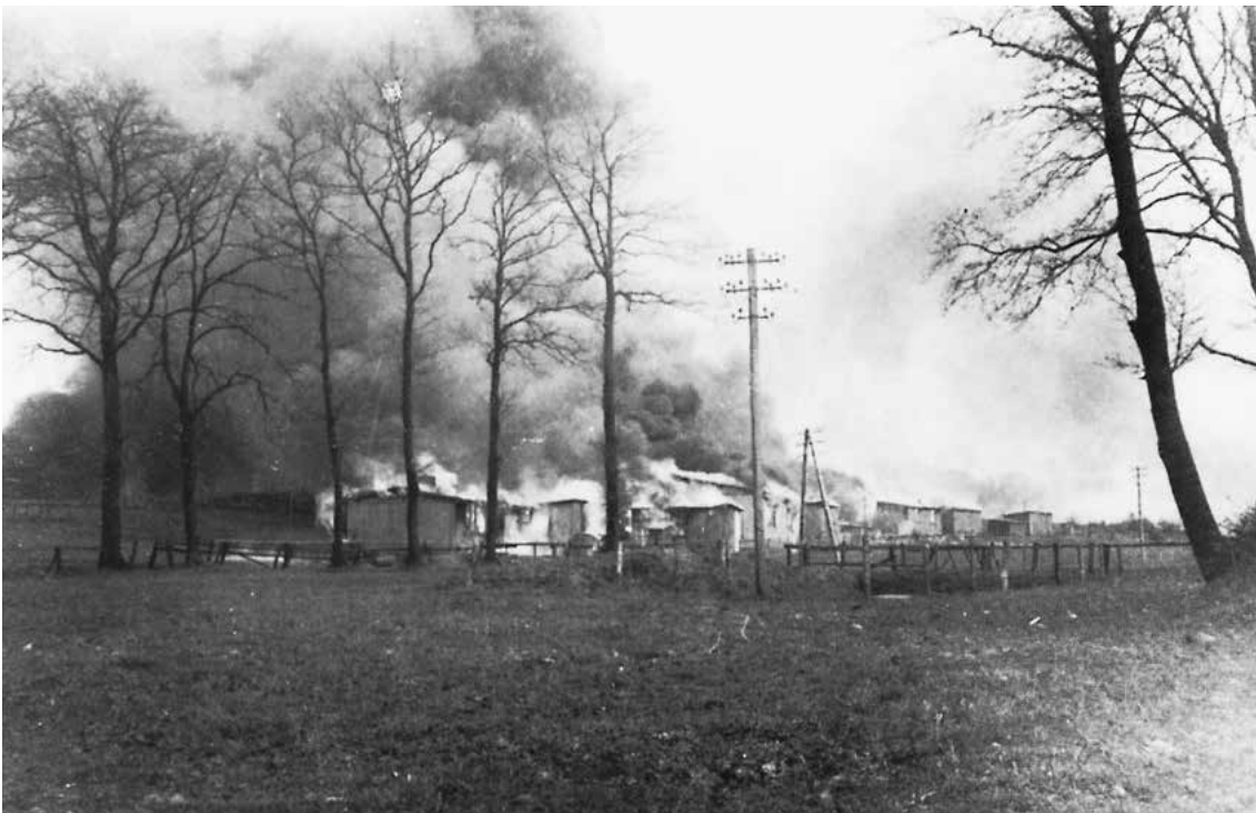
Brennende Wohnbaracken in Malbergen nach dem Abzug der deutschen Soldaten aus der Flakstellung beim Rittergut Osthoff. Kurz vor ihrem Abzug hatten die Bedienungsmannschaften die Geschütze und technischen Einrichtungen der Stellung zerstört und die Unterkünfte in Brand gesteckt. Heute erinnern nur noch einige in einem kleinen Wäldchen liegende halbverfallene Betonbunker an diese Episode des zweiten Weltkrieges in Malbergen.
