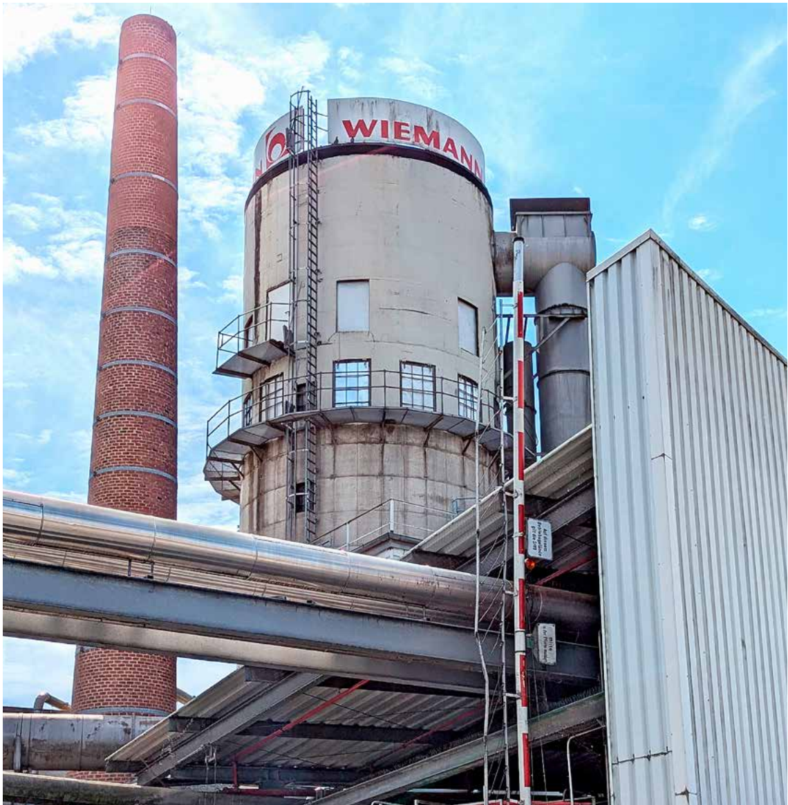
Der Spänebunker ist ein Problemfeld des Brandschutzes
