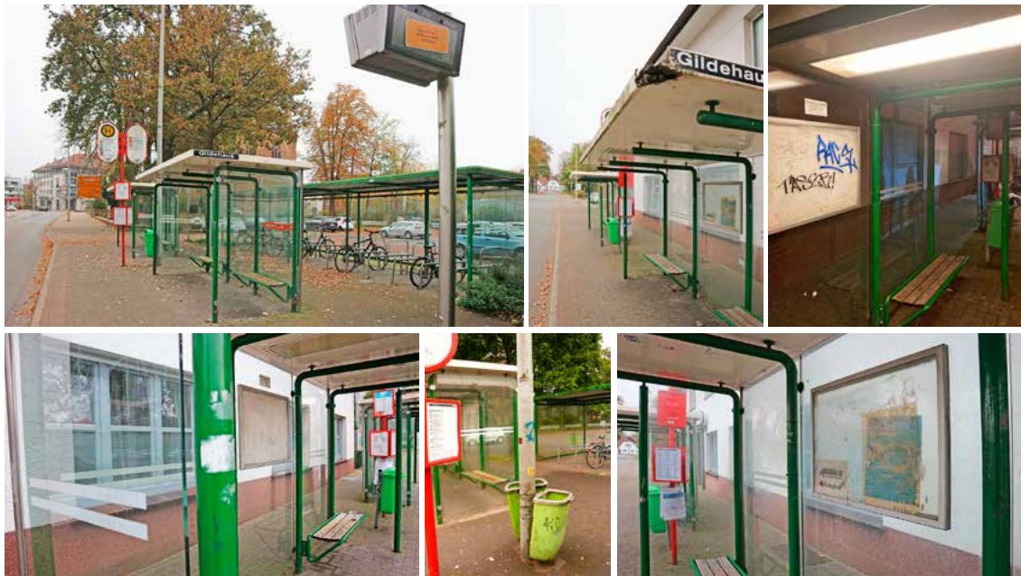
Aktuelle Bilder zum beklagenswerten Zustand der Haltestelle Gildehaus mit der seit Jahren defekten Anzeigetafel (2025)
