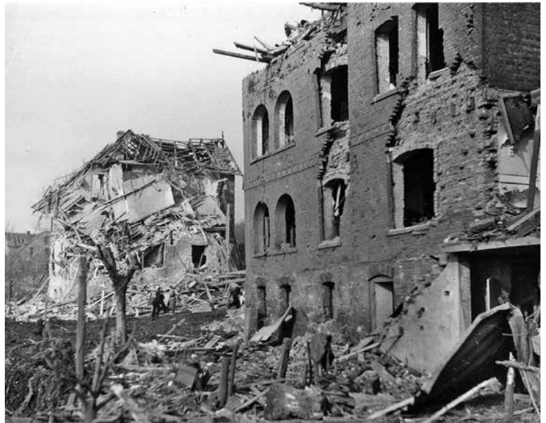
Eine Luftmine traf zwei Häuser am Osterberg, 1945
