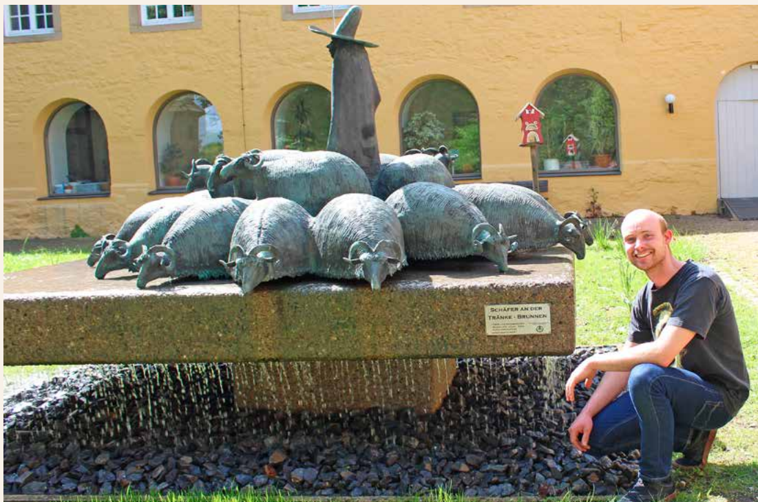
Simon Hagedorn hat den Schäfer-Brunnen in Osnabrück repariert
